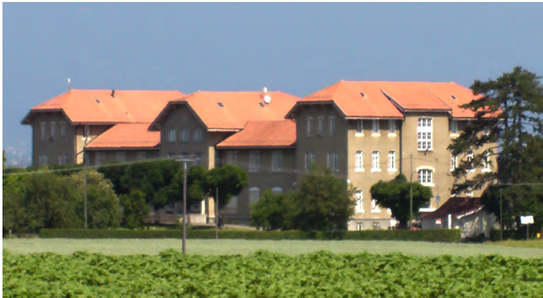
Le bâtiment de l'Institut Central ORT à Anières près de Genève aujourd'hui
